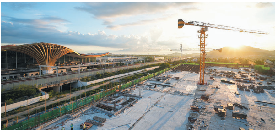
三亚凤凰国际机场三期项目停车楼工程施工现场。海南机场集团供图
