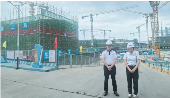
工作人员实地考察三亚国际免税城三期项目建设情况。 海南农商银行供图
