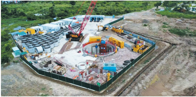
海南电网首条电力过江隧道始发井施工场地全景。周睿/摄
