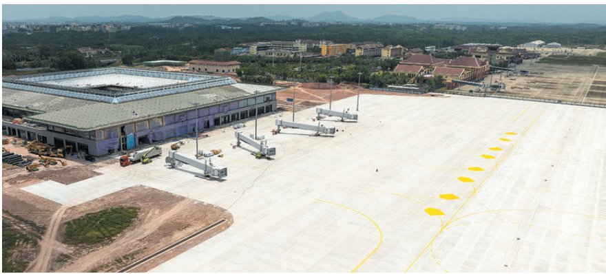
博鳌三期项目飞行区工程实景。海南机场集团供图
