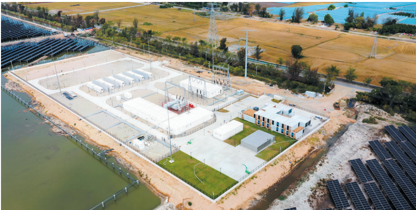
乐东莺歌海100MW光伏发电项目(二期)升压站航拍图。来源：海南交投
