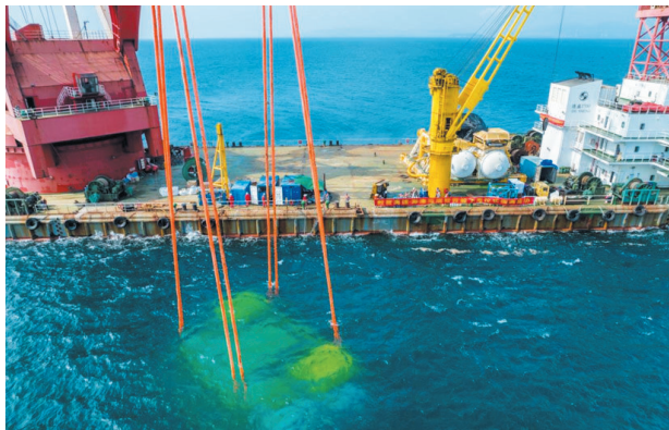
海底智算舱下水作业现场。 海南高速供图
