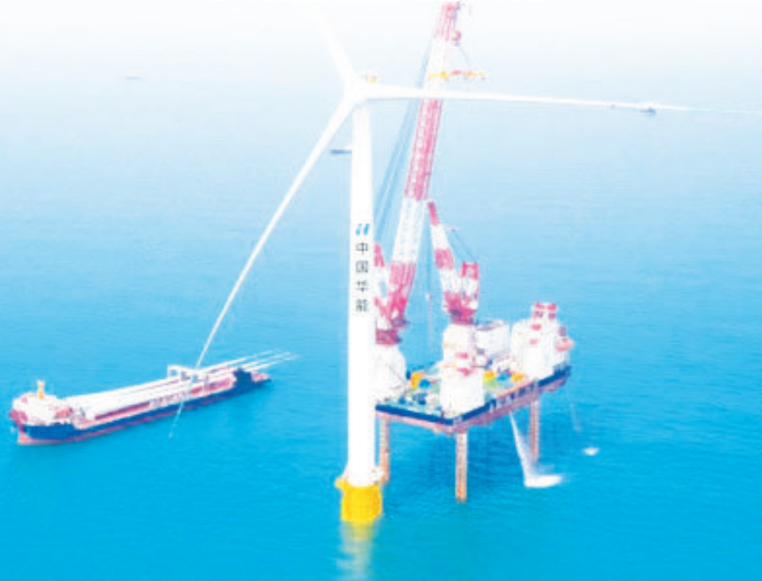
海南中行授信支持的华能临高海上风电项目安装的海南首台10兆瓦风机。 海南中行供图
