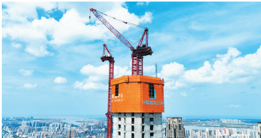
局部拆除顶模平台外挂架防护网片。海南机场供图
