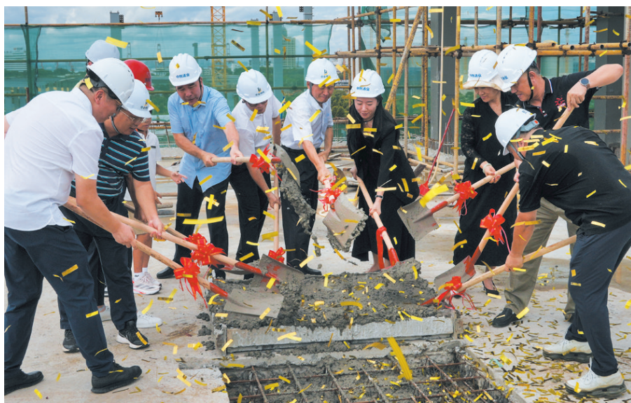
独凤轩·中熬汤业项目一期工程最后一仓混凝土浇筑完成。孙祥凯/摄
