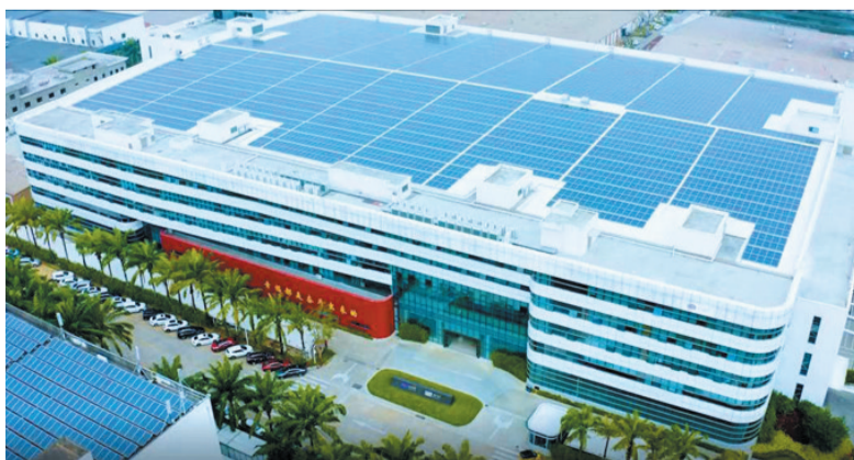
金盘科技海口高端干式变压器数字化工厂。金盘科技供图
