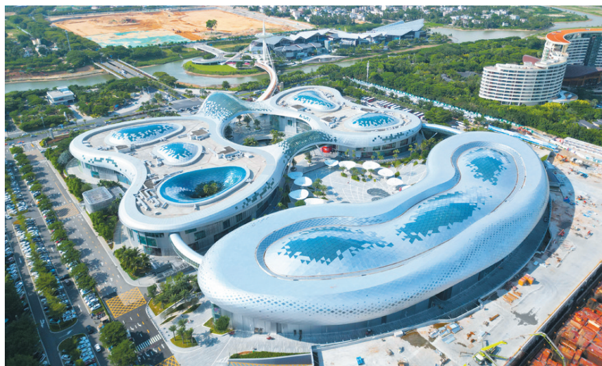
2023年10月25日,航拍三亚国际免税城一期二号地商业项目。李学仕 摄
