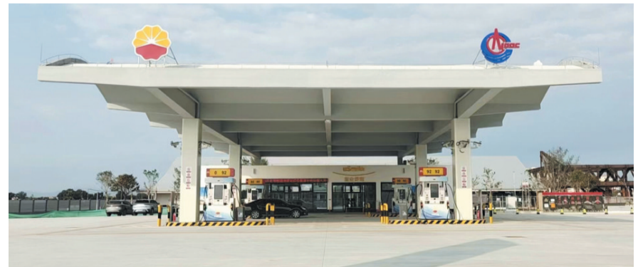
海控能源莺歌踏浪驿站综合能源补给站。海控能源供图
