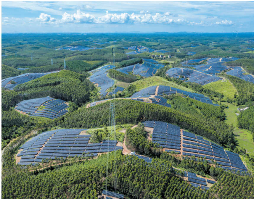
钦州市钦南区民海300MWp光伏发电平价上网项目鸟瞰图。 中国电建海南院供图
